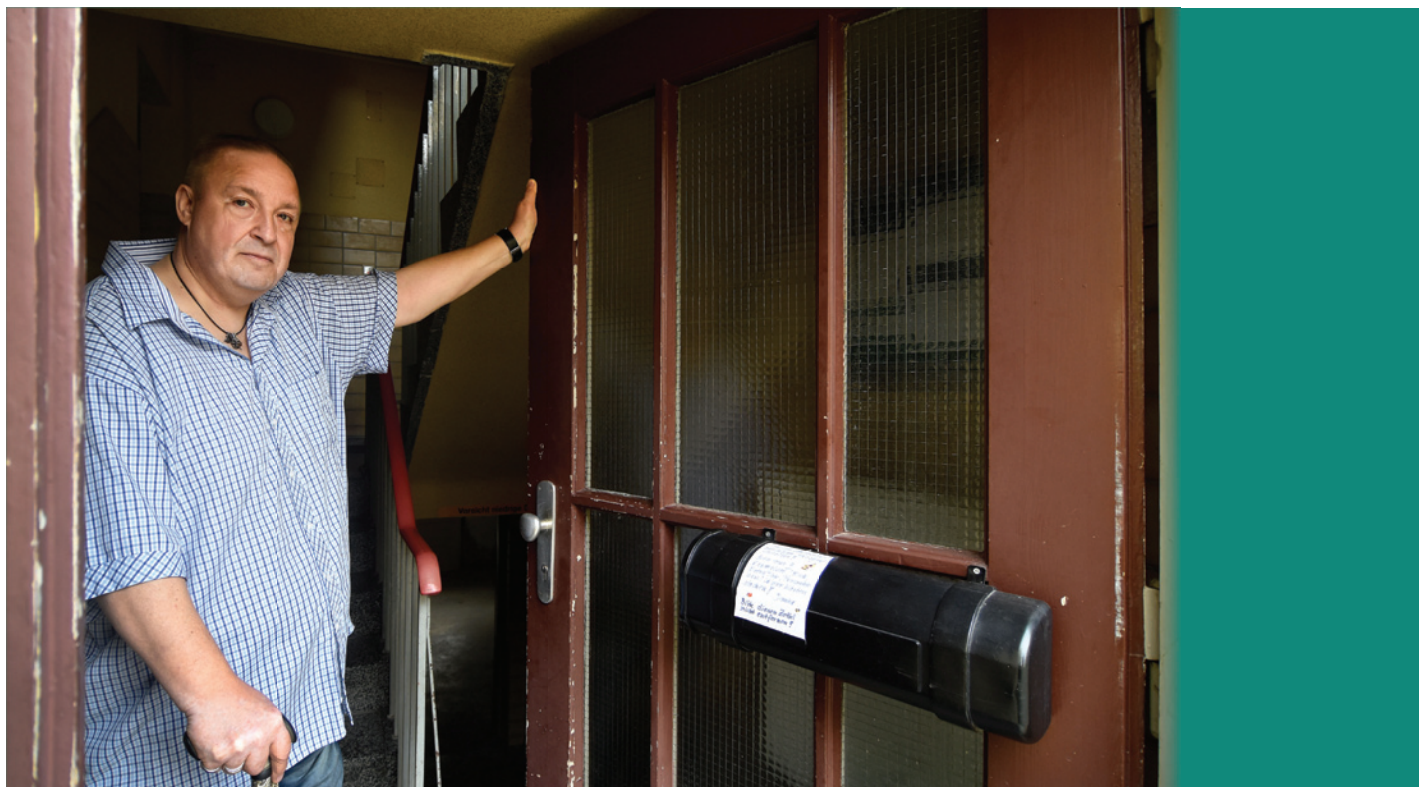
Ullrich Franke zeigt die Haustür, es zieht im Haus.
